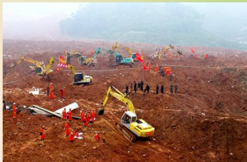
滑坡事故应急救援现场
