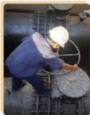
▲ 高峰供水前湖渚台深度处理工程管道铺设
