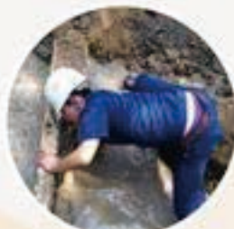
▲ 沈虹路DN150 铸铁管维修
