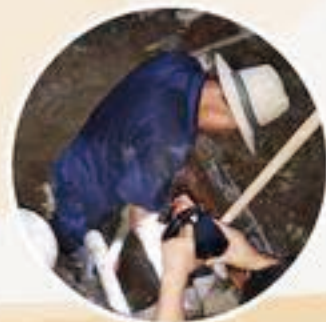
▲ 黄林清平西区 口径75单元管维修
