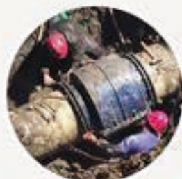
▲ 黎里增压泵站对南 侧DN600玻璃钢管检修
