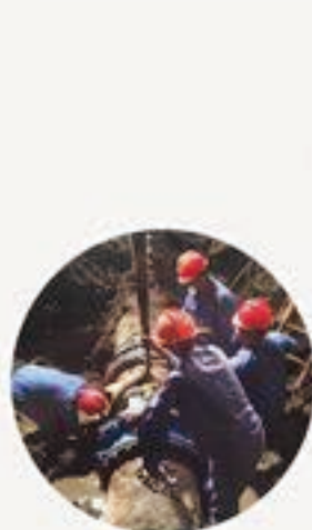
▲ 南康DN600 闸门老化更换
