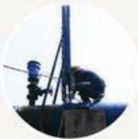
▲ 七都西亭子桥排气阀维修
