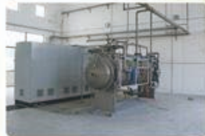
2017年7月 完成预臭氧接触池及配水井主体、臭氧制氧车间主体、预臭氧投运之配套工艺管道及氧气站施工,60万m 3 /d预臭氧系统完成试运行。
