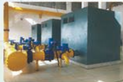
2017年12月26日 吴江区庙港水厂深度处理改造工程(一期)主体完工,工艺设备联动调试,进入带水试运行。
