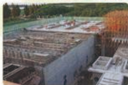
2017年3月 土建工程全面开工。
