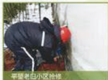
平望老旧小区抢修
