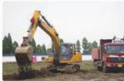
2016年6月 桩基工程全面开工。
