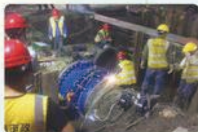
2017年4月 安装工程全面开工。
