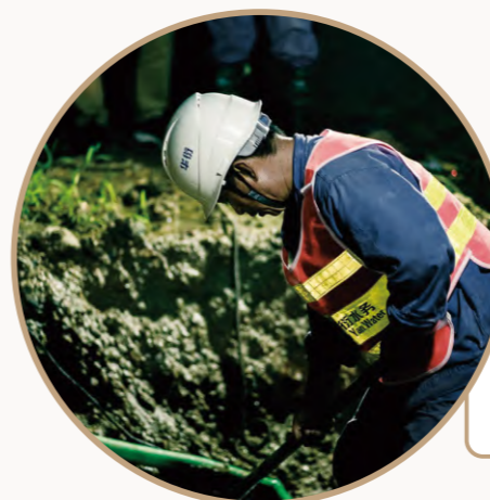
夜间管网抢修
