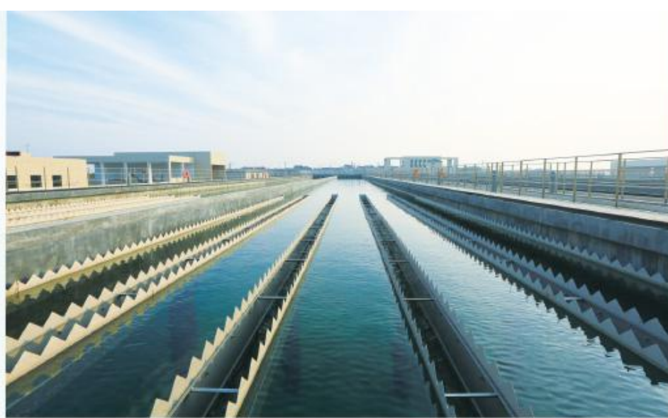
折板絮凝平流沉淀池
